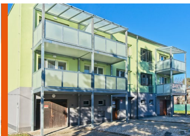
Kotvení lodžie do betonového základu mimo půdorys domu.
