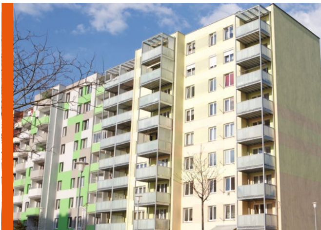
Samonosné ocelové lodžie je možné usadit až do výšky 8 poschodí.
