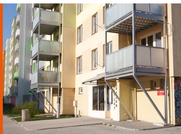
Kotvení lodžie do nosné obvodové zdi bez nutnosti betonového základu.
