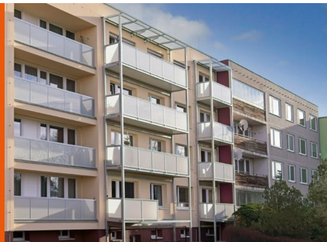
Samostatná lodžie 6 m x 1,2 m a 3 m x 1,2 m.
