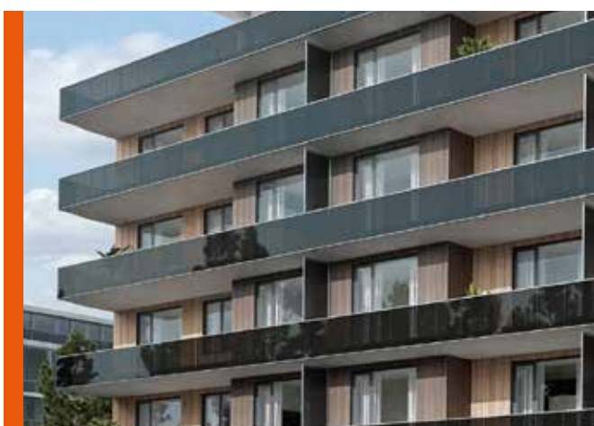
Tmavě lakované zábradlí s kouřovým sklem, bez spodního krycího plechu podél celé terasy bytového domu.
