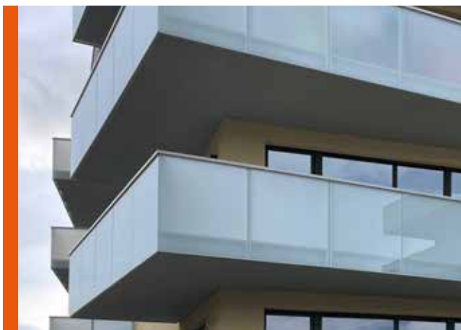
Hliníkové, stříbrně eloxované zábradlí umístěné podél betonové podesty, bez krycího spodního plechu.
