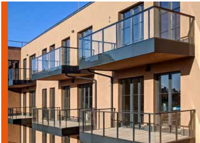
Hliníkové lakované zábradlí s čirým sklem na betonové podestě doplněno o spodní krycí plech.
